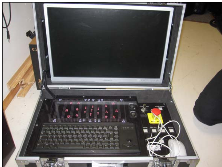
Abb. 3.7: Steuerung des Beschallungssystems des MUMUTH Graz
