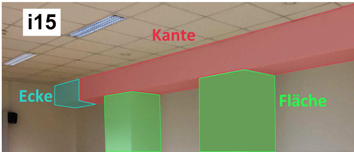
Abbildung 2.6: Markierte Bereiche des Kantenabsorbers.
