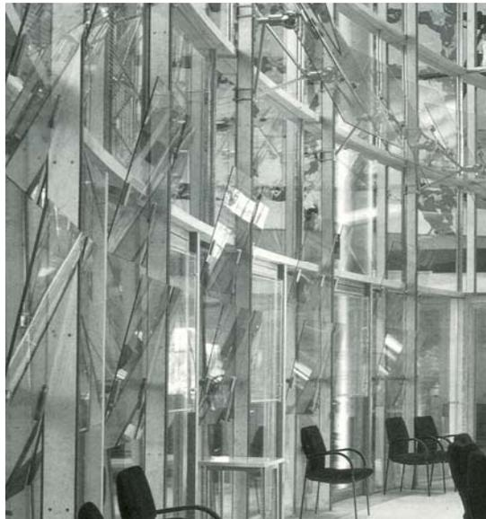
**Abbildung 2-41:** Einsatz mikroperforierter Plattenabsorber im Plenarsaal des Deutschen Bundestages (Bonn)<sup>30</sup>
