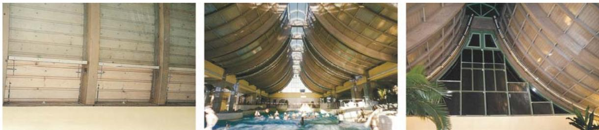
**Abbildung 2-39:** Einsatz mikroperforierter Folienabsorber im Freizeitbad „Die Welle“ in Gütersloh<sup>29</sup>
