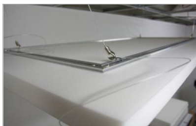
Abbildung 11: Deckensegel aus Melaminharzschäum mit Aluschiene zur Stabilisierung [SCHAUMSTOFFLAGER]
