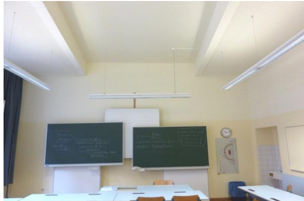
Abbildung 38: Akustische Sanierung mit Gipskartonlochplatten, Rückseite des Klassenzimmers
