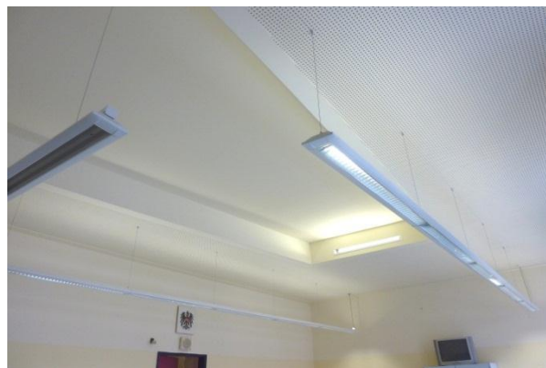
Abbildung 39: Akustische Sanierung mit Gipskartonlochplatten, Frontseite des Klassenzimmers
