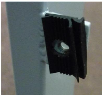
Abb. 135: Schraublasche mit Gummiauflage
