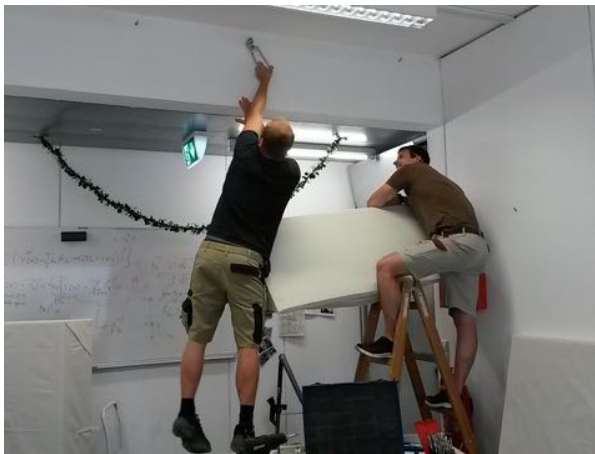
(a) Montage der Deckenabsorber
