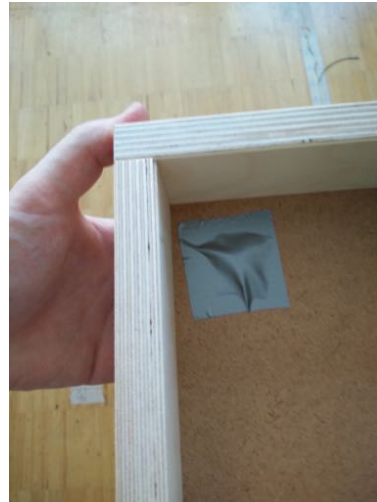
(b) abgedichtetes Loch
